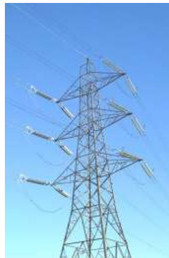
Figura 7 Estructuras o apoyos de anclaje
